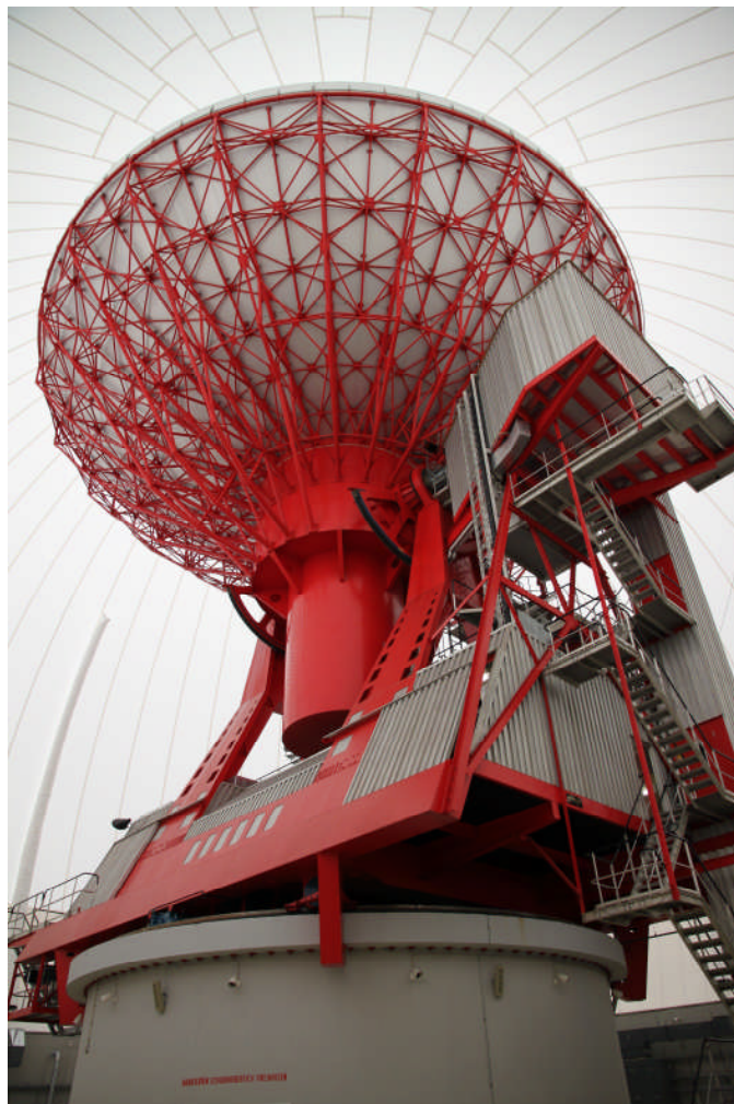
Das Radom von innen: Antenne 1 der Erdfunkstelle Raisting (Foto: René Jakob, Radom Raisting GmbH)
