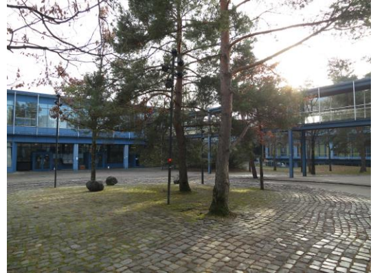
Das Blaue Palais in Fürstenfeldbruck: errichtet in Stahlbetonskelettbauweise mit Glasflächen und blauen Aluminiumverkleidungen. Foto: BLfD.
