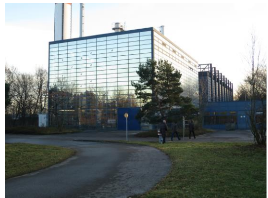
Die Heizzentrale: Im Vordergrund das Kesselhaus, eine Stahl-Glas-Konstruktion, und im Hintergrund das Kohlelager. Foto: BLfD.
