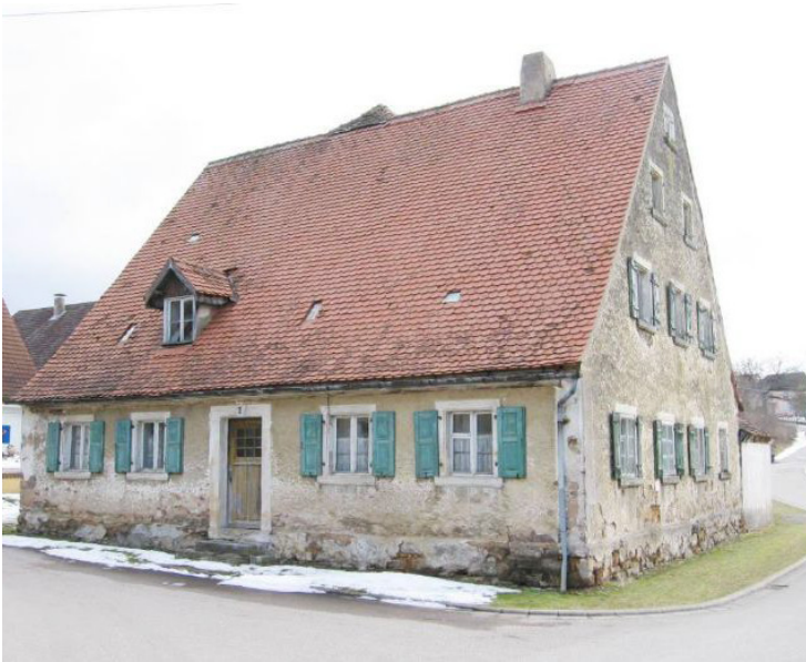
© (BLFD) Charmantes Wohnstallhaus
