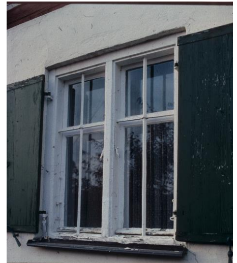
Fenster mit Brettläden, frühes 20. Jhd.
