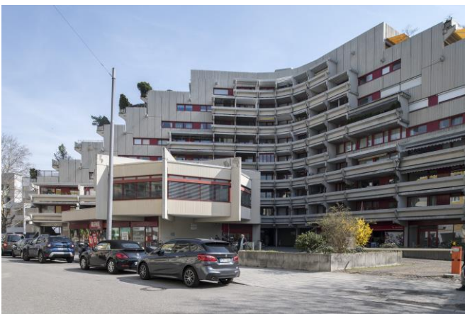
Längsseite mit Balkonen nach Westen. (Foto: BLfD, Michael Forstner)
