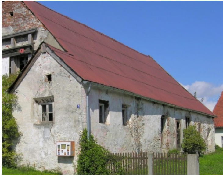
© (BLfD) Traditionelles Wohnstallhaus des 17. Jh.
