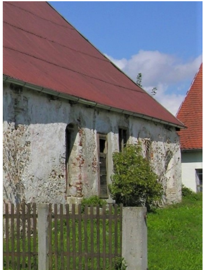
© (BLfD) Rundbogiges Eingangsportal
